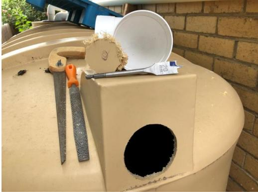
但是这个 90 毫米的排水口呢（储水罐满了之后把无法储存的水排进下水道）？不情愿花大几十澳元买个钻头只用一次，于是用 20 毫米的钻头沿着边缘一圈钻下来（左图，钻下来的中间部分在储水罐顶上），最后用锯子和锉刀修整成型。完成了！
