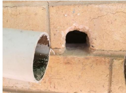
图 3. 断开下水管，墙上打个洞
