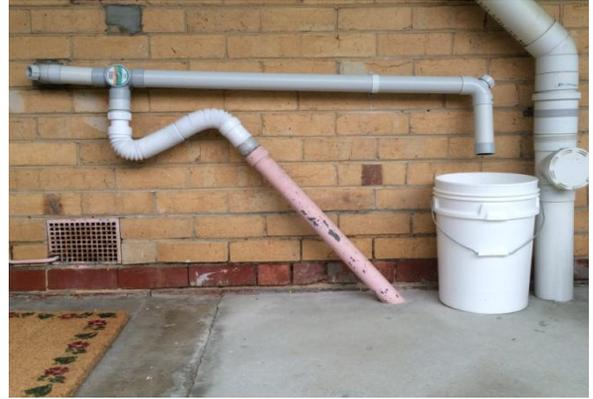
图 6. 改造后的接水桶和下水道
